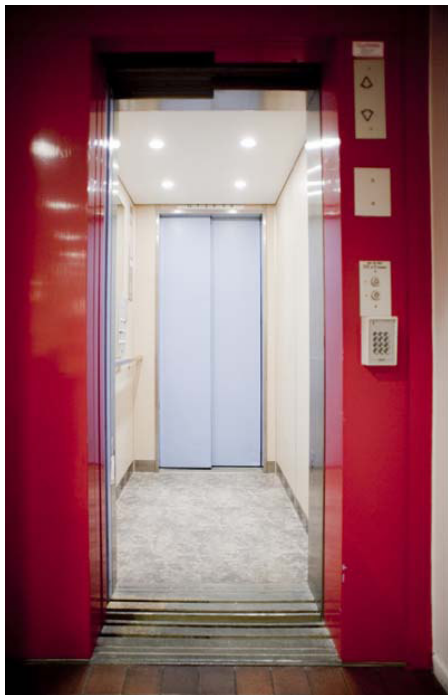
Figur 7.2. Hiss med närvarostyrd LED-belysning. Örebro Bostäder.
