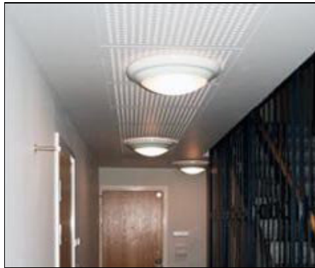
Figur 4.6. LED armatur för trapphus. Finns även med närvaroavkänning och tänd/släck- eller min/max-funktion för att slavstyra armaturer utan sensor. Armaturen ger ljus motsvarande 22 W kompaktlysrör. Dimbar till 10% via driftspänning. Källa: Energisystem, Nyköping.
